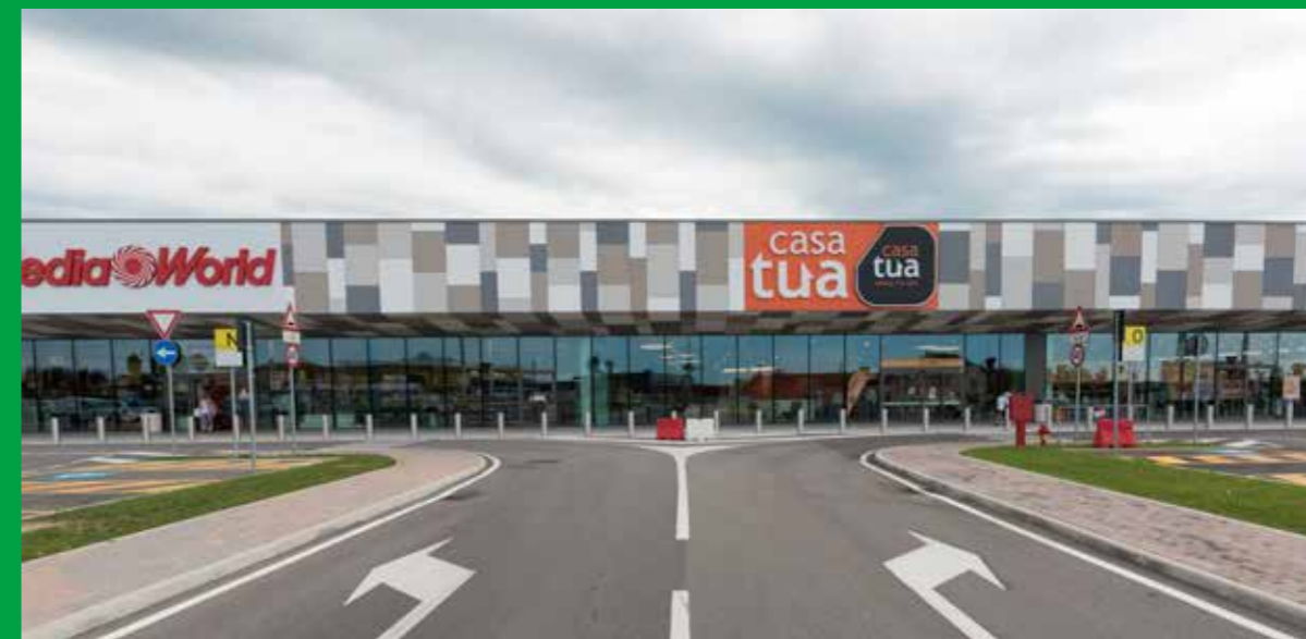
PARCO COMMERCIALE FIORE - SAN FIOR (TV) - TERMINE LAVORI
